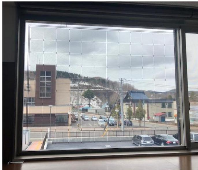
北海道上砂川町新庁舎の町長室窓に設置された太陽電池一体型シースルーガラス (2021年4月設置)
